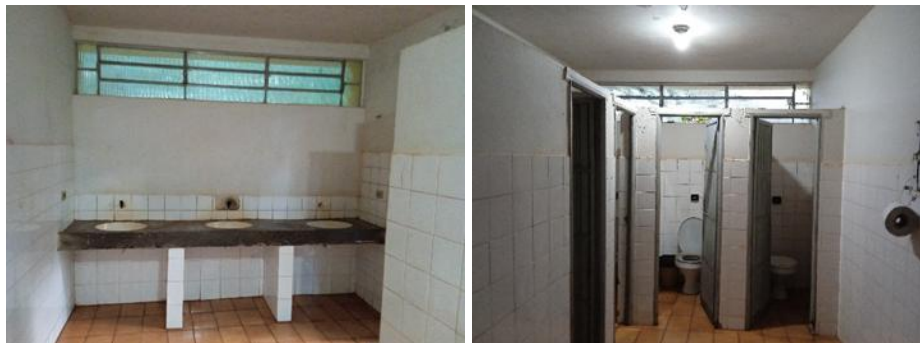
Figuras 4 e 5 – Banheiros do parque
